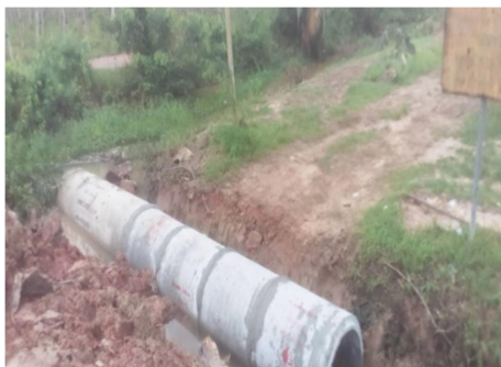
วางท่อระบายน้ำคสล.(มอก.ชั้น๓) ถนนสายโคกไม้ไผ่ - เกาะมัน หมู่ที่ ๗
