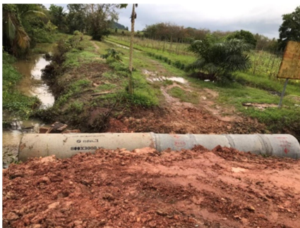
วางท่อระบายน้ำคสล.(มอก.ชั้น๓) ถนนสายโคกไม้ไผ่ - เกาะมัน หมู่ที่ ๗
