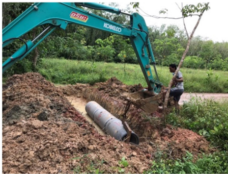
วางท่อระบายน้ำคสล.(มอก.ชั้น๓) ถนนสายเกาะกลมออก หมู่ที่ ๑๒
