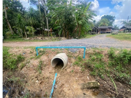
วางท่อระบายน้ำคสล.(มอก.ชั้น๓) ถนนสายเกาะกลมออก หมู่ที่ ๑๒
